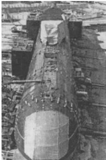
Подготовка подводной лодки «Комсомолец» к спуску на воду.
